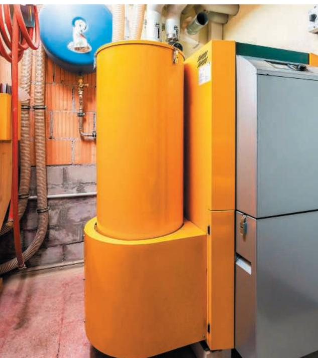
Die Ölheizung wurde durch ein erneuerbares Heizsystem mit Holzpellets ersetzt.
