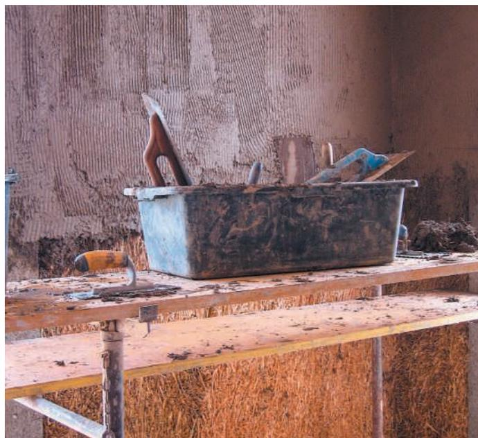
L'enduit de terre crue recouvre la paille qui isole les murs de l'intérieur.
