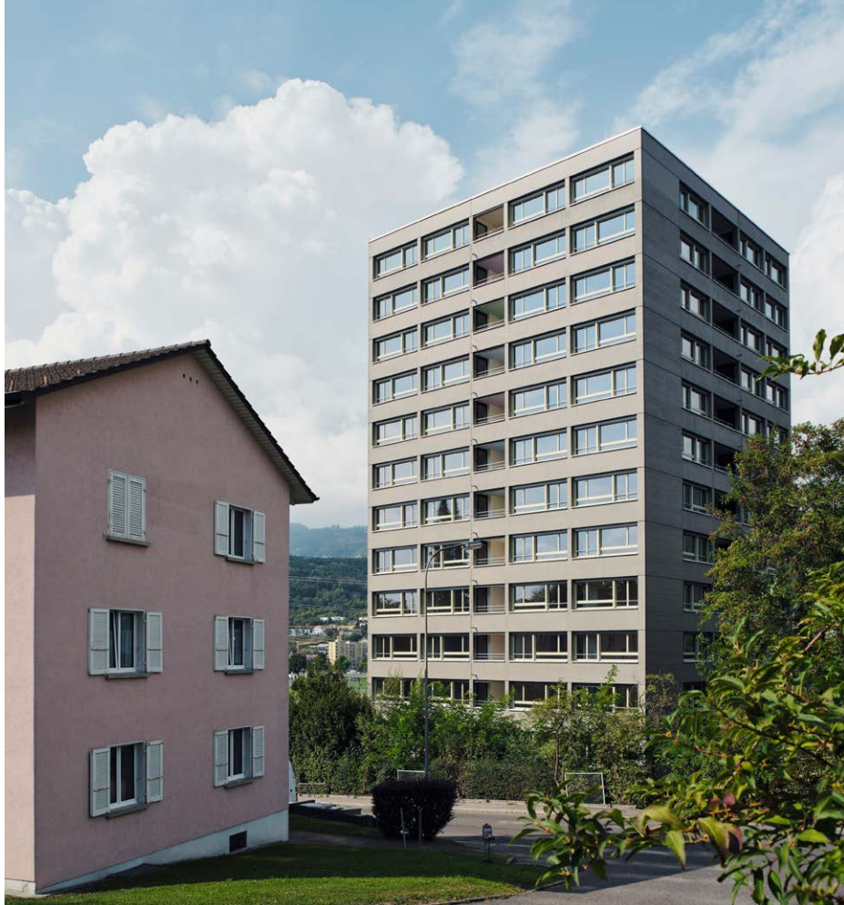
Das erste Genossenschaftshochhaus der Stadt Biel im neuen Kleid.
