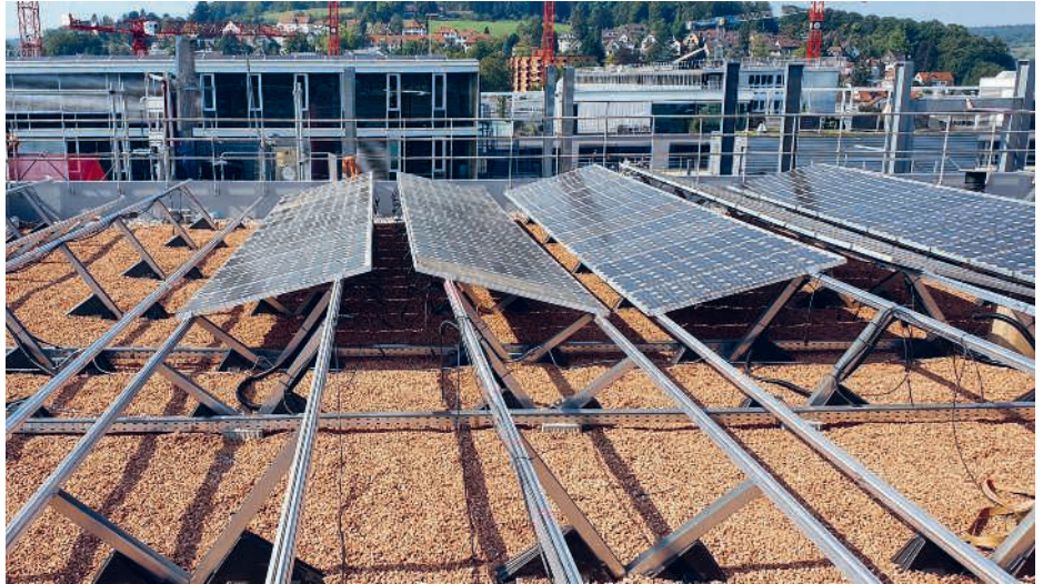
Statt im Abfall gelandet, sind diese Solarzellen auf einem zweiten Dach zum Einsatz gekommen.
