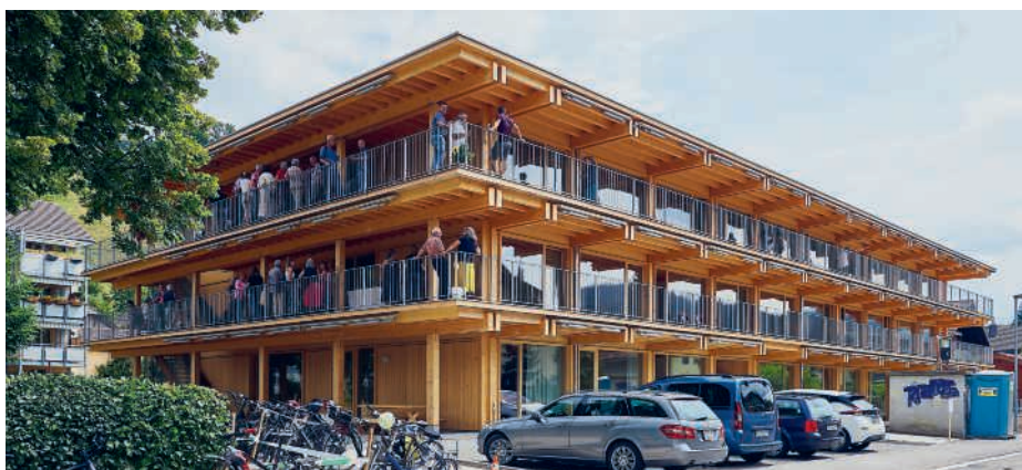
Von mehrheitlich lokalen Handwerkern mit lokalem Baustoff gebaut: das Generationenhaus Langnau im Emmental.
