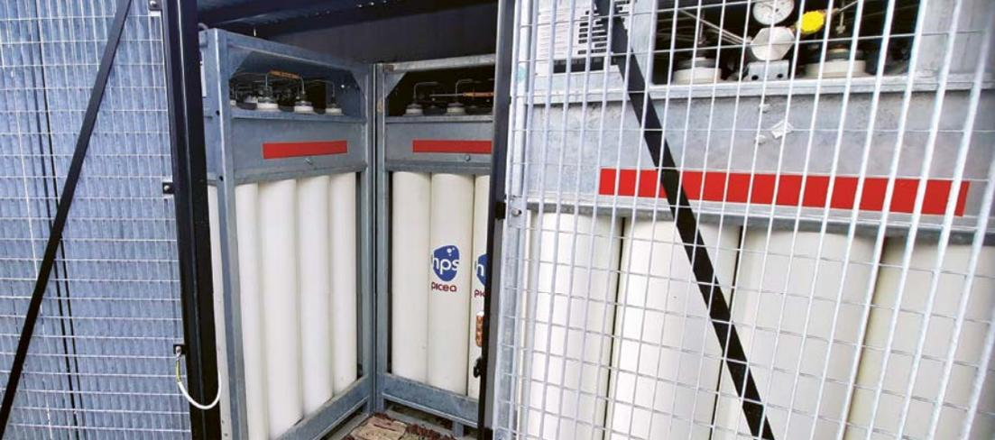
In diesen Flaschen wird der Wasserstoff gespeichert.
