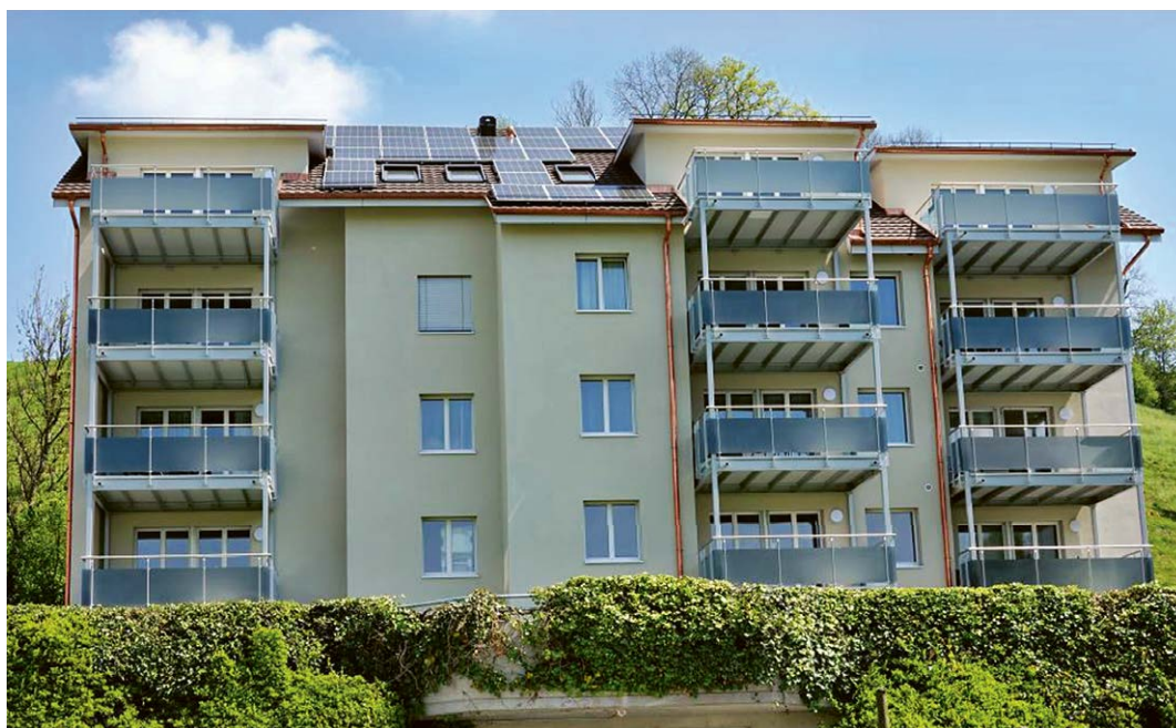
... und nach der Sanierung – dank Sonderprogramm des Fonds de Roulement.
