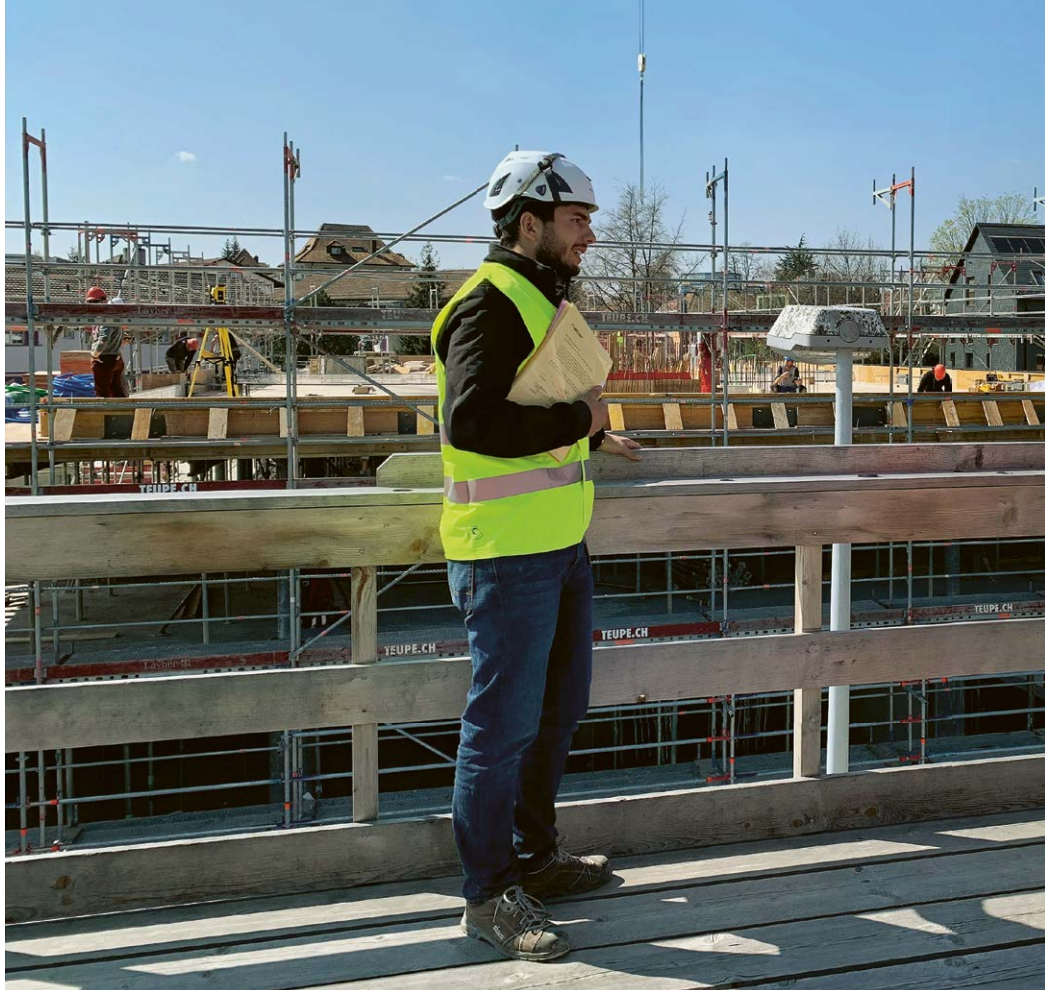
Guy Parmelin recueille des informations sur un chantier.
