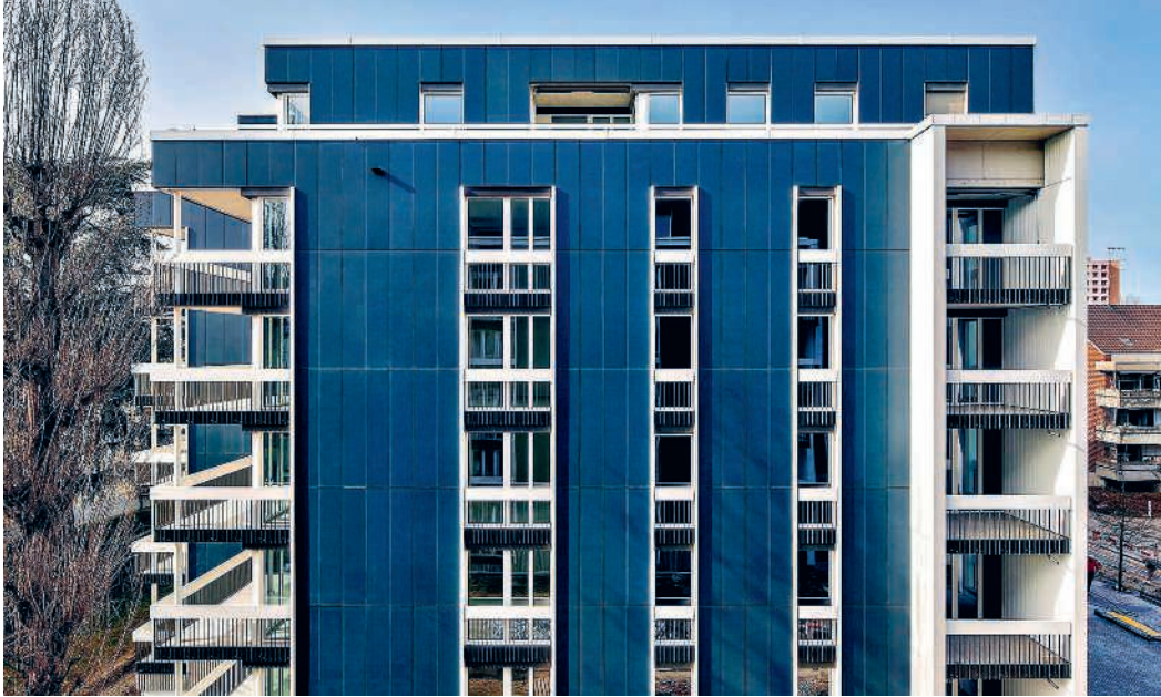
Fotovoltaik als Teil der Fassadengestaltung: Die Siedlung Heuwinkel der Graphis. In der Kategorie B Neubauteilen wurde die Siedlung mit dem Schweizer Solarpreis ausgezeichnet. Le photovoltaïque fait partie de la conception des façades: le lotissement Heuwinkel de Graphis. Dans la catégorie B Nouvelles constructions le lotissement a été récompensé par le Prix solaire suisse.
