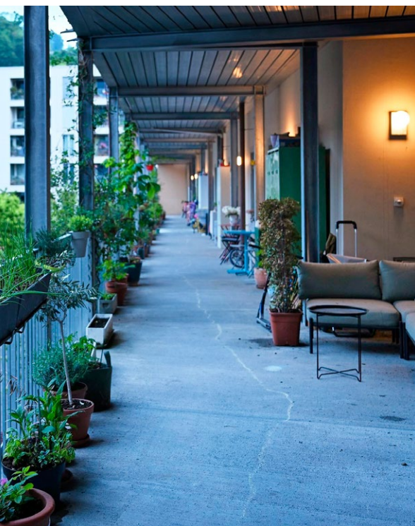
Der sanierte Bestandesbau mit Lauben auf dem Teiggi-Areal. Bild: Juliette Überschlag
