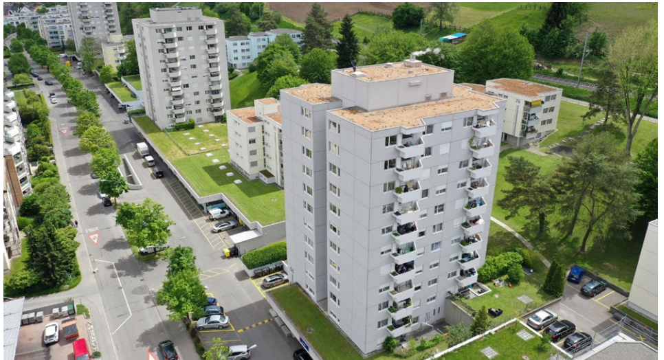
Die drei Hochhäuser der Gemeinnützigen Baugenossenschaft Röntgenhof Zürich in Schlieren stammen aus den 1970er-Jahren. Bei der Gesamtsanierung mussten die geschützten Betonelementfassaden erhalten bleiben. Eine zusätzliche Dämmung war deshalb nicht möglich. Ein Beispiel dafür, wie Denkmalschutz und Energiewende in Konflikt geraten können.
