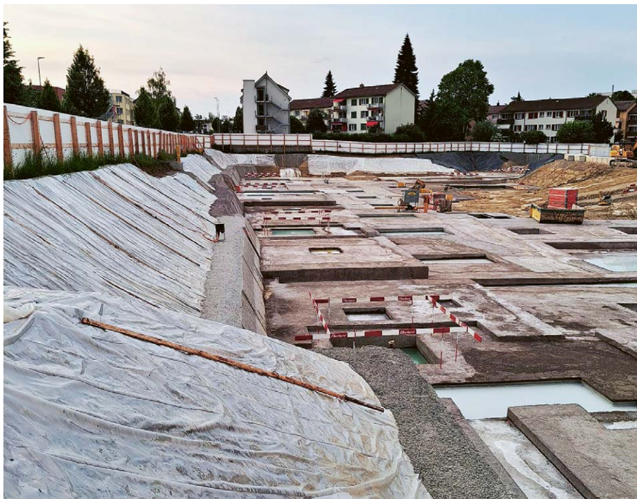
Baufortschritt der Bauetappe 1 der Baugenossenschaft Röntgenhof in Rümlang.
