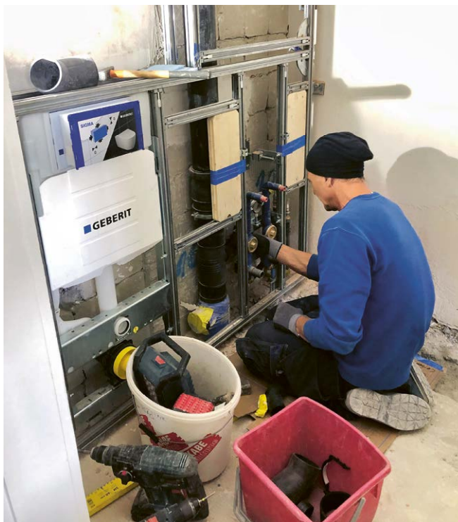
Bäder, Leitungen, Installationen werden Strang um Strang ersetzt.
