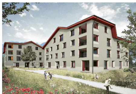
Neubau Kreuzmatte, Meggen.
