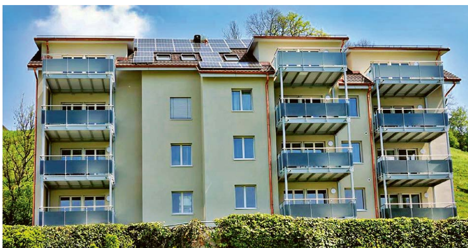
Mehrfamilienhaus Menznau vor und nach der Sanierung.
